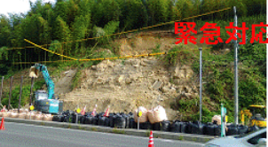
桑名インターと交差する県道の地すべり。隣接してふくらみ亀裂が入った法面
