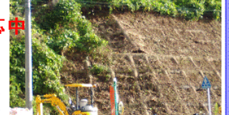
桑名インターと交差する県道の地すべり。隣接してふくらみ亀裂が入った法面
